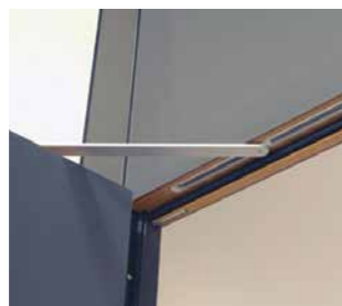
Boîtier OTS2 Ferme-porte caché avec linguet mécanique
