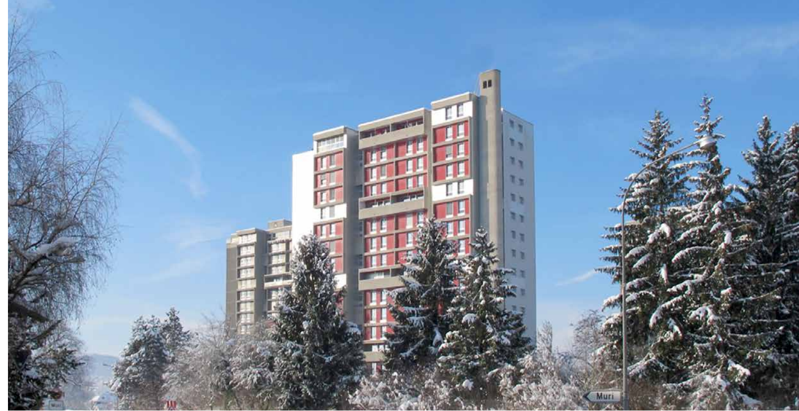
Sanierung eines Mehrfamilienhauses in Muri bei Bern
