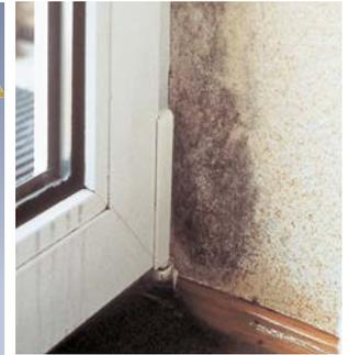
Formazione di muffa a causa di aerazione insufficiente.
